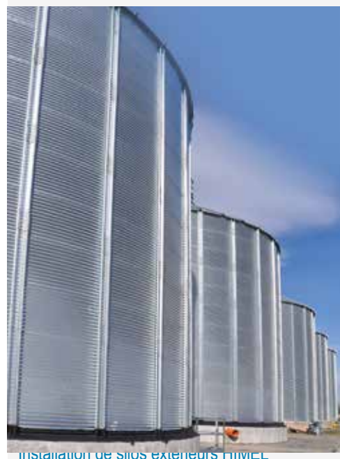
Installation de silos extérieurs HIMEL
