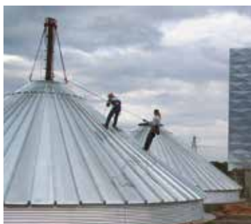
Montage du toit de silo
