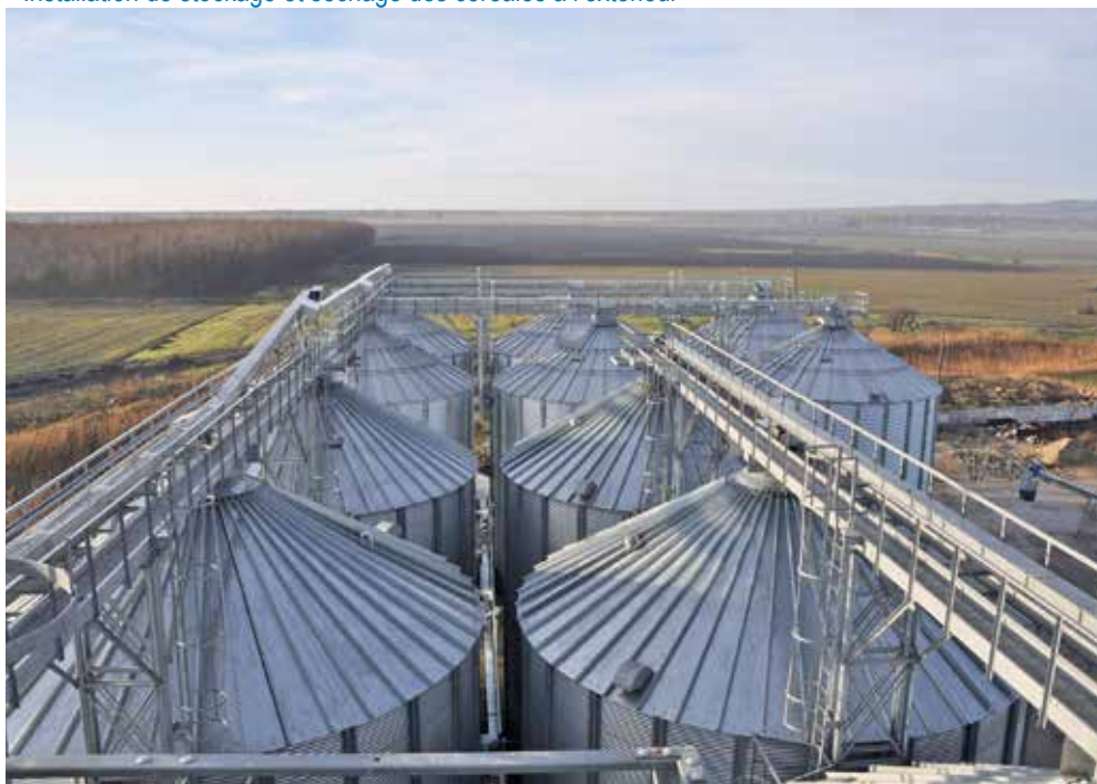
Installation complète avec échelles d'accès et de toit
