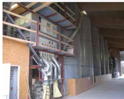
Système avec 4 000 t de stockage et nettoyeur vibrant
