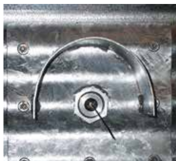
Détecteur de niveau à palette rotative
