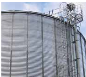
Élévateur en extérieur
