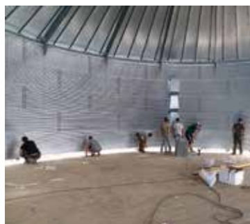
Montage du silo, vue intérieure
