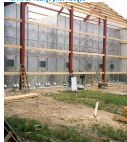
Montage d'un silo rectangulaire avec plancher ventilé pour la vidange pneumatique
