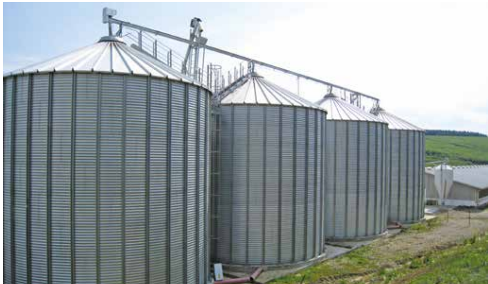
Silos extérieurs HIMEL, remplissage par vis en auge
