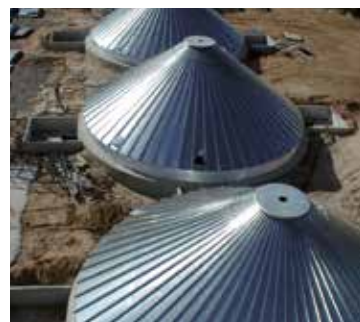
Montage du toit
