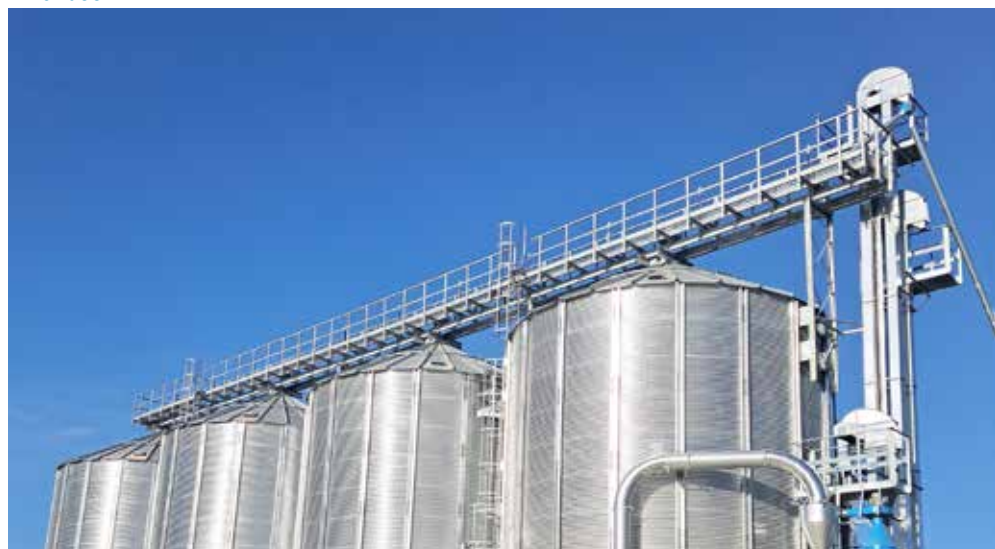
Convoyeur à chaîne HIMEL au dessus de silos extérieurs
