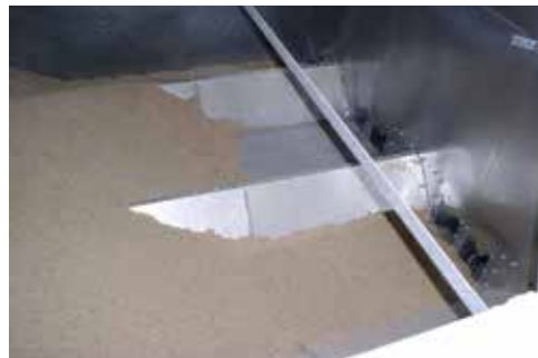
Caniveau de ventilation à faîtière installée
