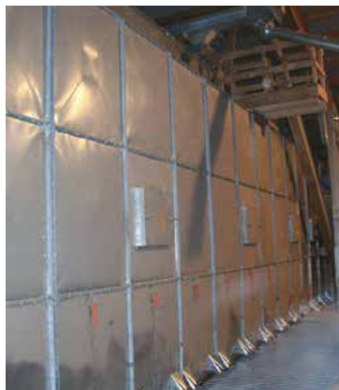
Silo de stockage rectangulaire avec trappe de vidange pour la fosse de réception
