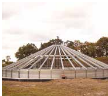
Ossature du toit de silo
