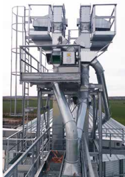
Élévateur à godets avec échelle et plate-forme de travail
