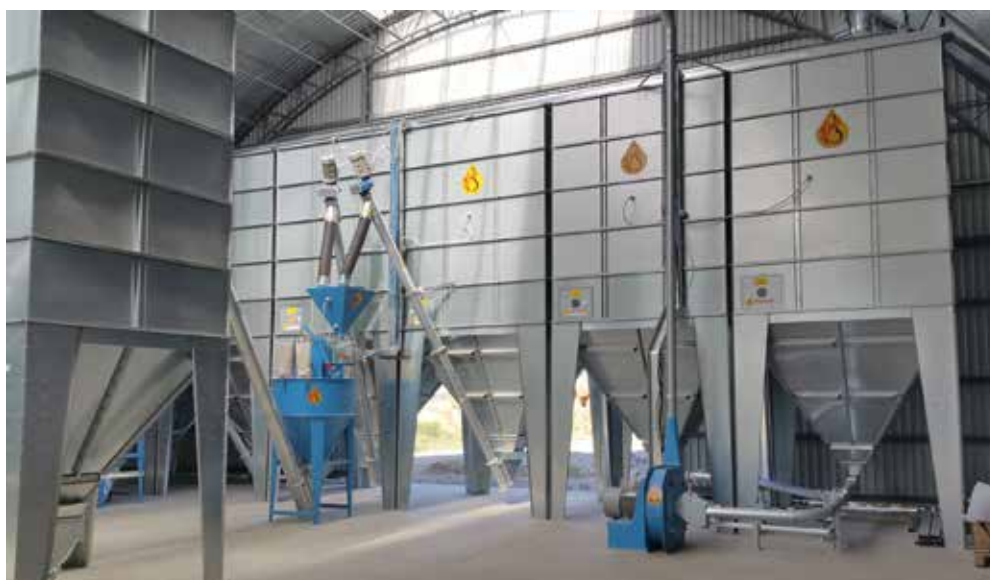
Fabrique d'aliments avec boisseau 60° comme silos tampons
