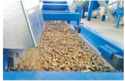
Pelletkühlung mit Vibrationsrinne
