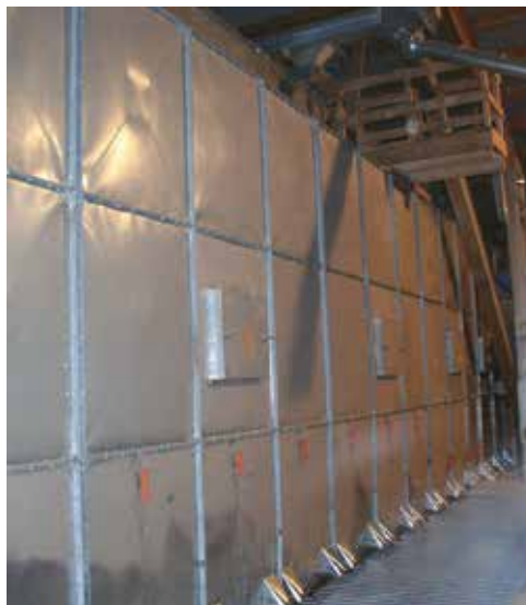
Rechteck-Lagersilo mit Auslaufschieber zur Getreideannahmegasse
