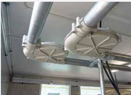
Rohrkettenträger in Stallanlage
