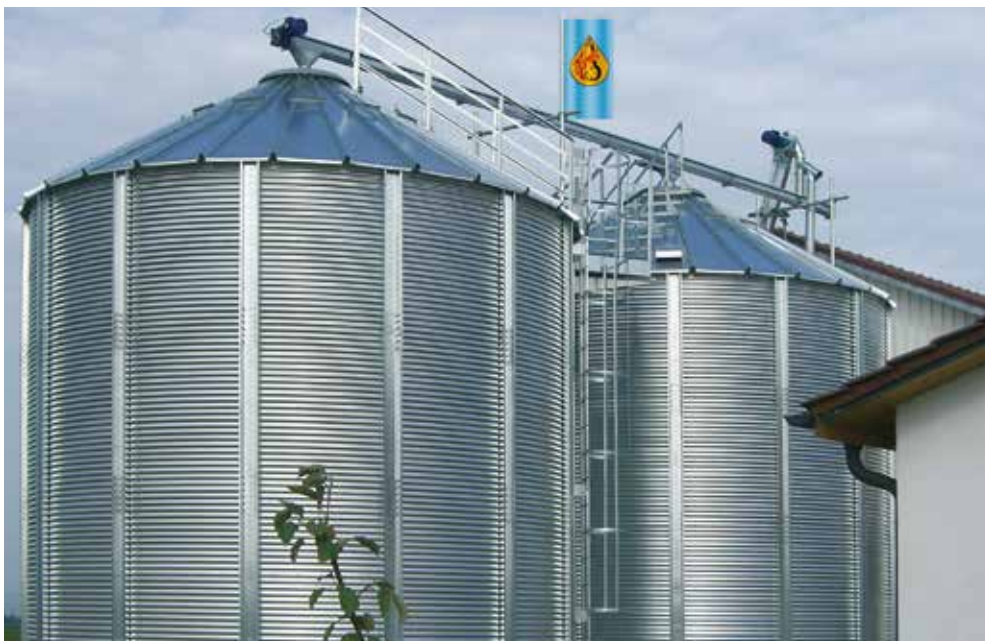
HIMEL Aussensiloanlage mit Kettenelevator und Trogschnecke
