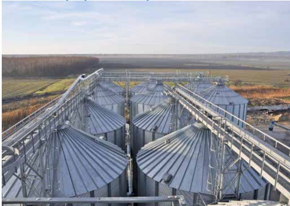
Außensiloplanlage mit Dach- & Aufstiegleitern
