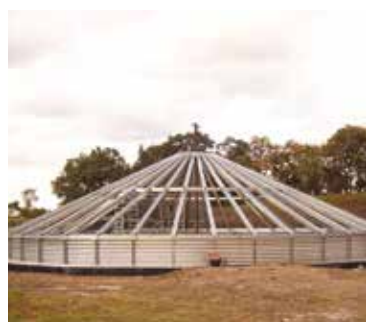
Aufbau Silodach
