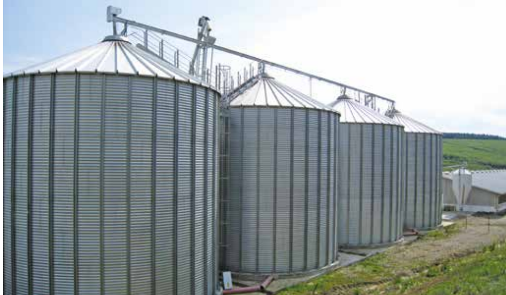
HIMEL Außensilos mit Befüllung über Trog-schnecken
