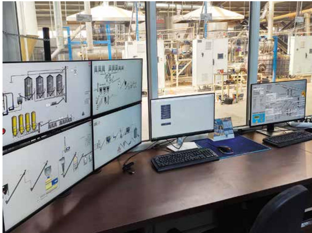
Steuerung einer Mahl- und Mischanlage mit HIMEL Wiegecomputer
