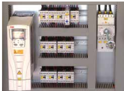
Frequenzumformer in Schaltschrank eingebaut
