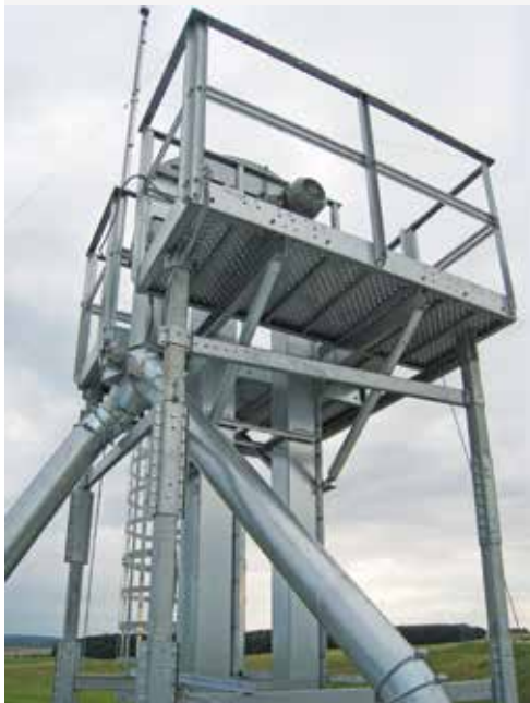
Becherelevator mit Bedienpodest
