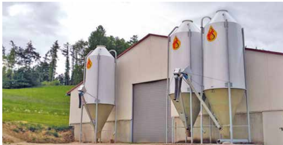
GFK Mischfuttersilo mit Förderschnecken per Funk
