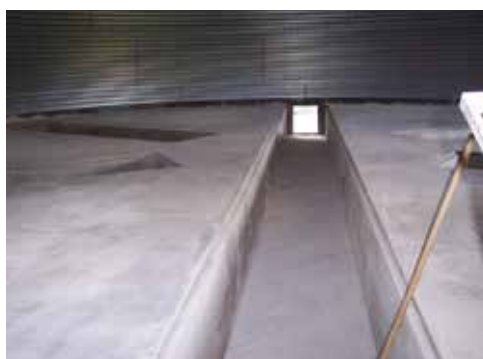
Außensiloanlage mit Laufstegen und Getreidebelüftung
