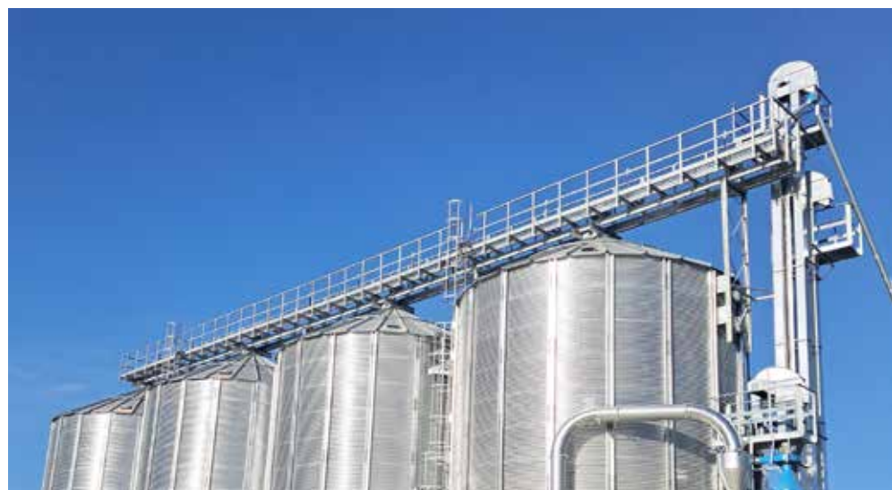
HIMEL Trogkettenförderer über Außensiloanlage
