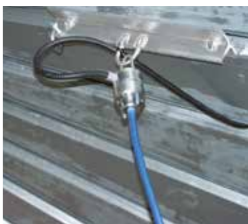
Aufhängung unter Silodach
