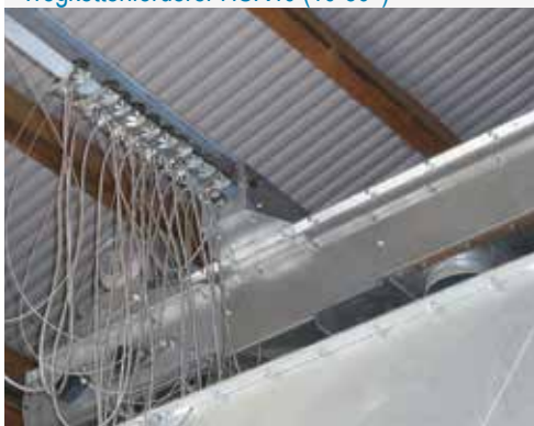
Laufschiene Trogkettenförderer
